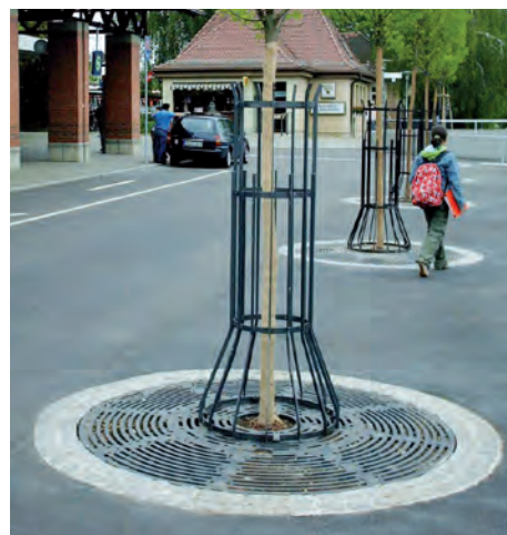
Fellbach nära Stuttgart - Tyskland Wotan Markgaller skyddar rotzonen från komprimering och säkerställer tillräcklig syretillförsel och vattentillgång.
