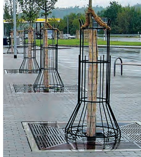
Rhön West, bensinstation och rastplats - Tyskland Under tillväxtåren skyddas de unga träden från vindlast med hjälp av stamskyddet
