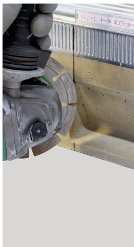
Kapning av ränna till rätt storlek
