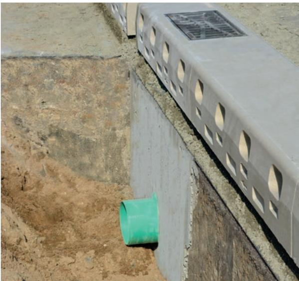
Für die Inspektion und Wartung der KerbDrain Bridge steht eine klappbare große Revisionsöffnung zur Verfügung. Der Aufsatz klappt längs zur Brückenkappe. Unter der Revisionsöffnung befindet sich der Anschluss zur Brückentwässerungsleitung, über den die Spülung der Leitungen ebenfalls erfolgen kann.
