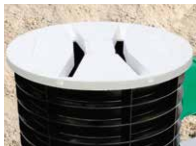
Skyddslocket skall vara kvar under hela tiden som återfyllning pågår
