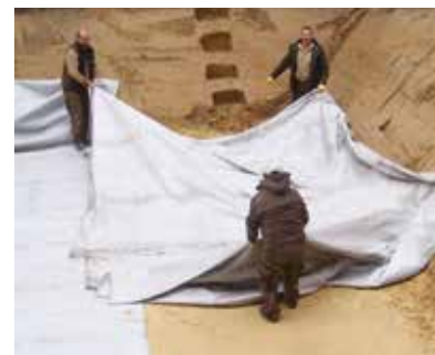
Schaktbotten och sidor täcks in med fiberduken
