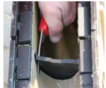
6. Kapning av sandfångarens vägg mot anslutningsränna
