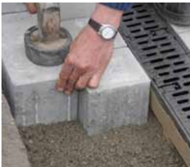
7. Stensättning mot rännkanten
