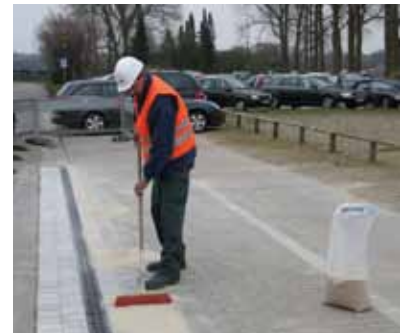
8. Fyllning av fogar med kvartssand
