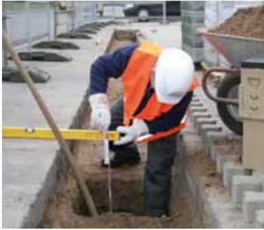
1. Schakt för installation av en V 75 P-ränna. Ta måttet till rännans bygghöjd
