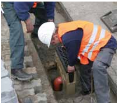
4. Montering av löv/sandfång och anslutning till ledning
