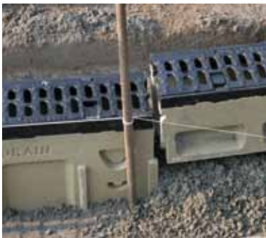
5. Montering av rännan med fjäder-not system
