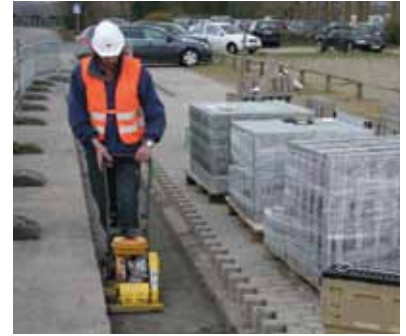
3. Anpassning och komprimering av fundament
