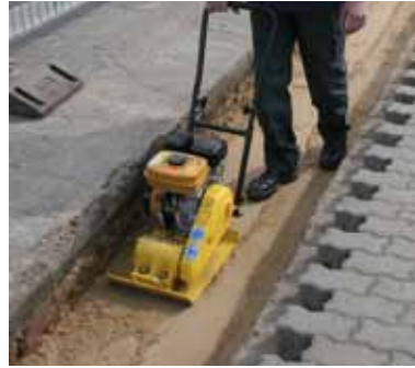
2. Anpassning och komprimering av ytan
